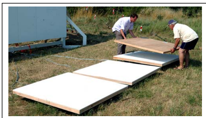
Mise en place des panneaux
